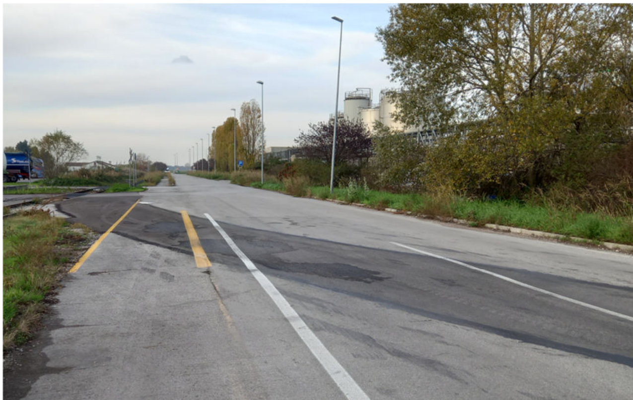
Figura 2 Attraversamento sud di via Majorana, con il ripristino della pavimentazione lungo il vecchio tracciato.
